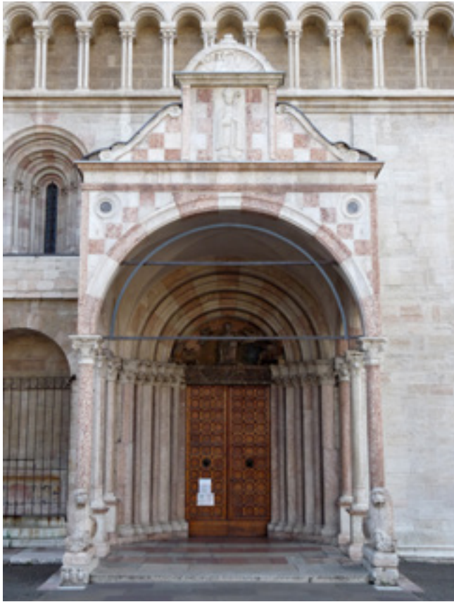
Trento, cattedrale di San Vigilio, veduta del protiro e del portale settentrionale
